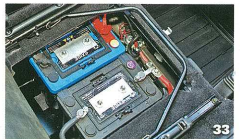
Voilà le résultat. Une installation compacte et efficace, restant facile d'accès et ne modifiant aucun élément d'origine. À l'exception des petits trous dans la caisse, l'opération inverse ne laisse donc aucune trace.
